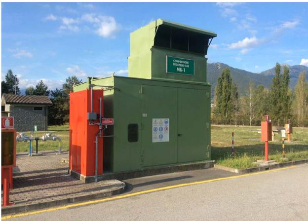
**Descripción de medidas:** Cuando los compresores o las tuberías de las estaciones de compresión se ponen fuera de servicio por motivos operativos o de mantenimiento, el gas se despresuriza por venteo. Esta emisión puede evitarse dirigiendo el gas a un sistema de baja presión conectado o cercano, o utilizando un compresor eléctrico para redirigir el gas.
