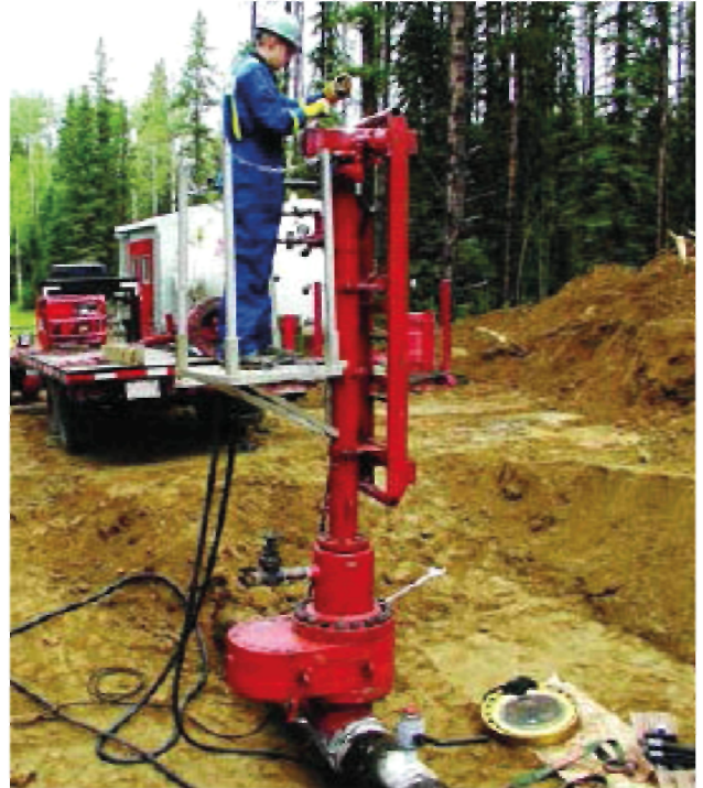
Рисунок 4: Пример добавления зажимного устройства к трубопроводу 2
