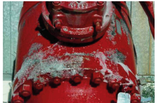
Рисунок 2 3 : Проверка на наличие утечек посредством мыльного раствора
