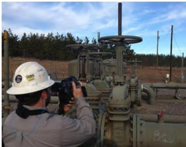
**Description du programme :** depuis 2014, SWN a commencé à effectuer des campagnes de détection des gaz par imagerie optique (optical gas imaging, OGI) sur les sites impliquant des puits nouveaux et modifiés et sur les stations de compression de gaz de collecte, conformément à la réglementation fédérale américaine (NSPS OOOOa). SWN a été au-delà des exigences réglementaires :
