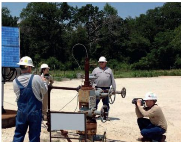
Figure 3 : caméras OGI en cours d'utilisation
