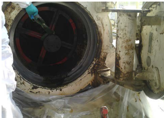
Рисунки 2а и 2б: Работы по очистке скребками
